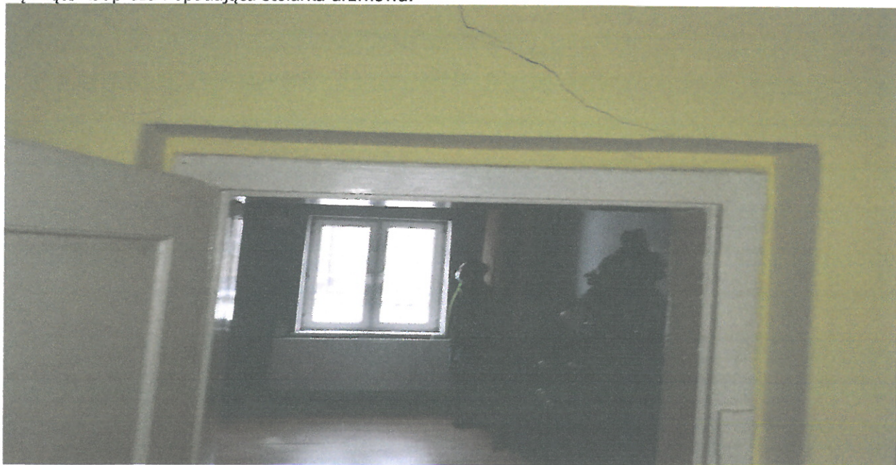
Pęknięte nadproża i opadająca stolarka drzwiowa.
