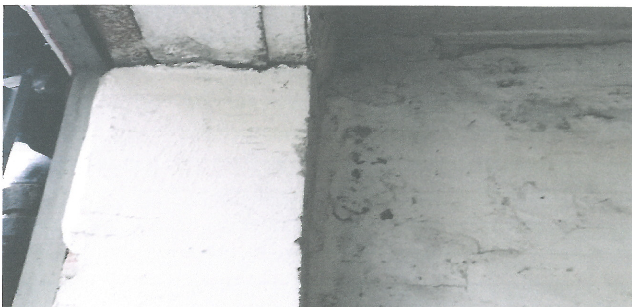
Budynek garażowy niski.
