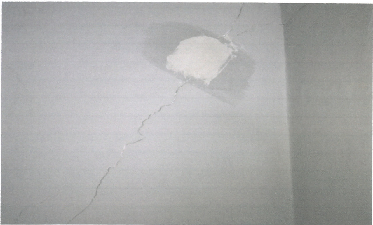
Ta sama ściana po przeciwnej stronie.
